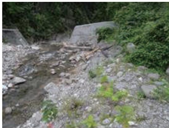
図5 増水による侵食状況 (左)植栽時 (右)侵食後 (溪流に近い約80%の植栽木が流された)
